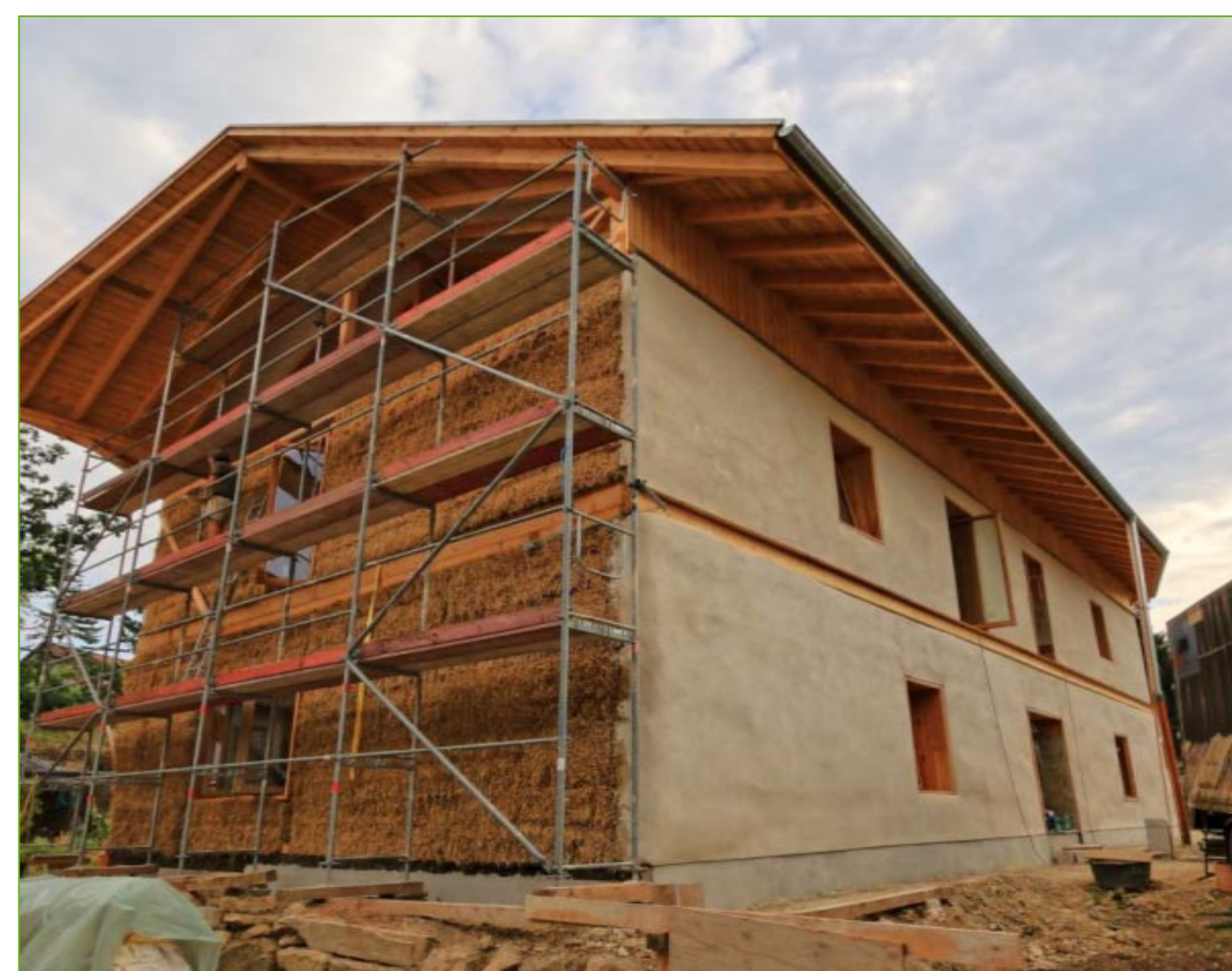
Beispiel für den Bau eines Strohballenhauses in Weimar/Ehringsdorf
