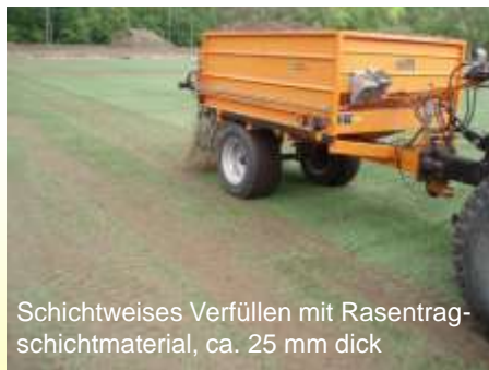
Schichtweises Einarbeiten des Materials und Einsaat
