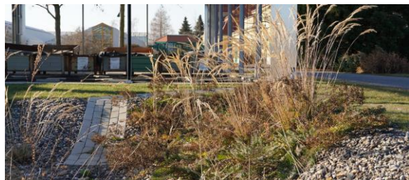
Zeitgemäße Versickerungsanlagen in Dresden-Pillnitz: Tiefbeet auf dem Schlossparkplatz (links), bepflanzte Mulde auf dem Gelände der Überbetrieblichen Ausbildung des LfULG (rechts)
