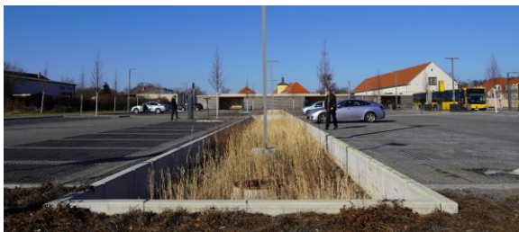
Zeitgemäße Versickerungsanlagen in Dresden-Pillnitz: Tiefbeet auf dem Schlossparkplatz (links), bepflanzte Mulde auf dem Gelände der Überbetrieblichen Ausbildung des LfULG (rechts)
